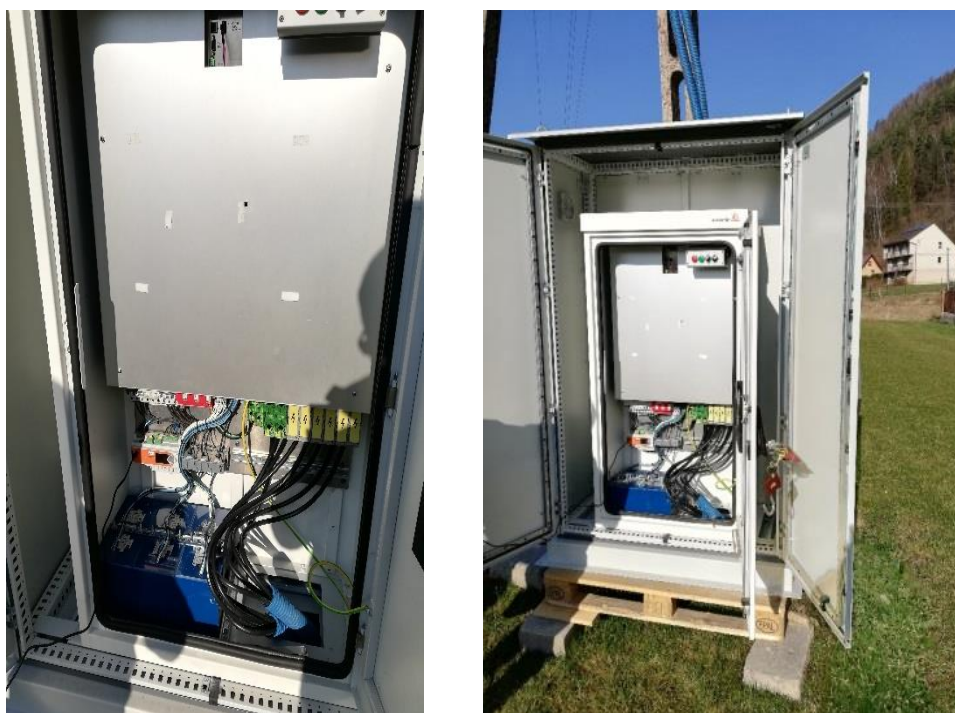
Rys. 7.39. Widok szeregowego regulatora napięcia typu LVR przyłączonego w punkcie M8 obwodu niskiego napięcia zasilanego ze stacji transformatorowej SN/nN „X”
