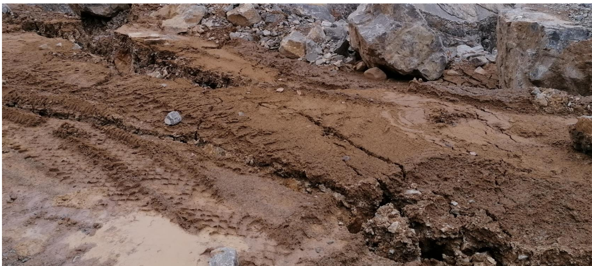
Rys. 10. Oderwanie się fragmentu ściany w rezultacie pęknięcia. Źródło: materiały własne KWC.
