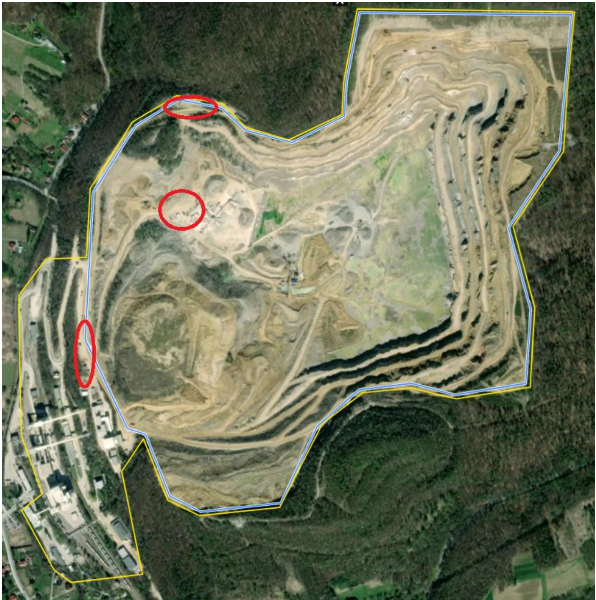
Rys. 47. Mapa obszaru górniczego KWC. Kolorem czerwonym oznaczono zabezpieczone przed dostępem osób nieuprawnionych miejsca postoju maszyn w nocy i w dni wolne od pracy. Źródło: fotografie wykonane dla KWC.
