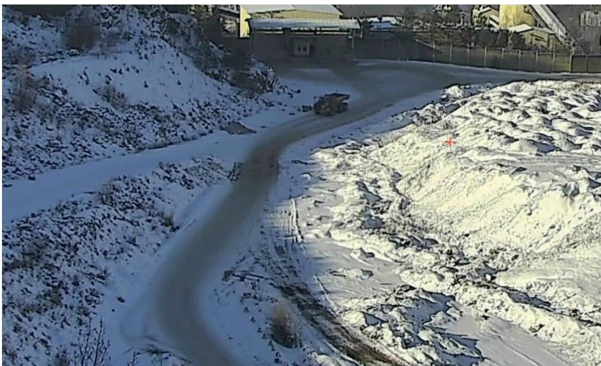
Rys. 53. Doły zasypowe, początek ciągu technologicznego „Zakład Przeróbczy”. Źródło: materiały własne KWC.
