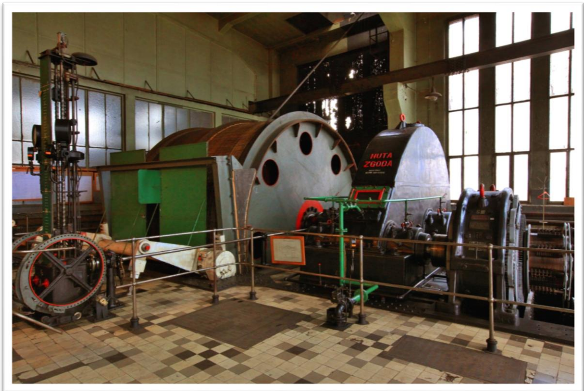
Zdjęcie 1-7. Maszyna wyciągowa szybu Andrzej III wschód. 2013 rok[2].
